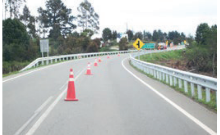
Conservación Caminos Provincia de Chiloé con defensas camineras. Modelo TVH1W4A-1
