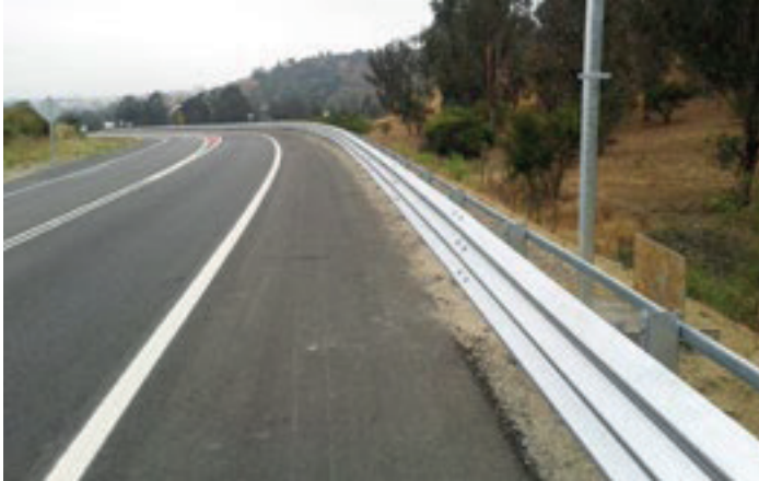
Defensas certificadas en Construcción Ruta F-50 Quilpué. Modelo TVH2W5A-2
